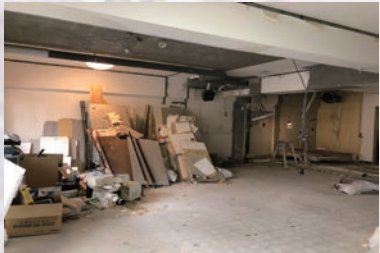
②フルリノバージョン 解体中
